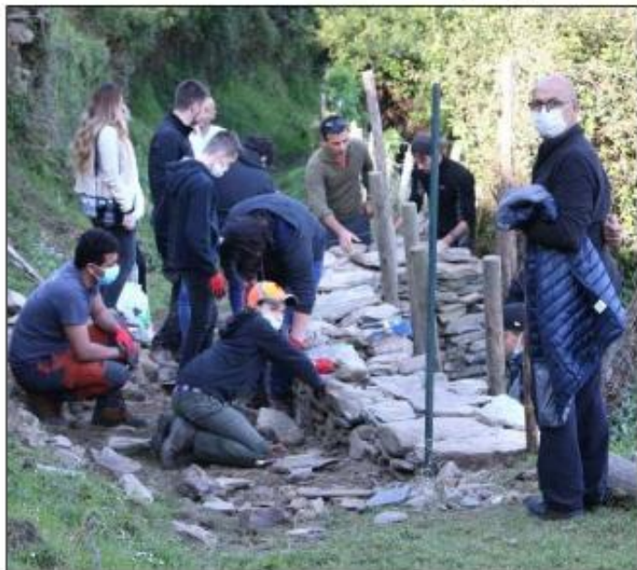
Chantier Erasmus sur le sentier du patrimoine.
